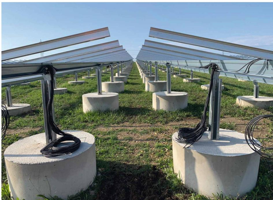
Kompromiss: Hybridfundamente kommen mit weniger Beton aus als reine Betonfundamente.
