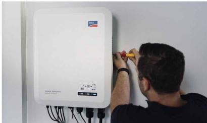
Seit Beginn dieses Jahr gibt es einen DC-gekoppelten Hybrid-Wechselrichter aus dem Hause SMA, in vier Leistungsklassen zwischen fünf und zehn Kilowatt. Speicher können mit bis zu 30 Ampere be- und entladen werden. Im Falle eines Stromausfalls errichtet der Wechselrichter binnen 30 Millisekun-
