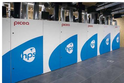
Der Hersteller von Ganzjahres-Wasserstoffspeichern Home Power Solutions hat seine Produktpalette um eine Lösung für Gewerbeanlagen erweitert. Der „Förster“ ist eine Steuerungseinheit, die bis zu zehn der Wasserstoffsysteme picea (lateinisch „Fichte“) verbinden kann. So ließen sich bis zu 15.000 elektrische Kilowattstunden speichern. Zudem
