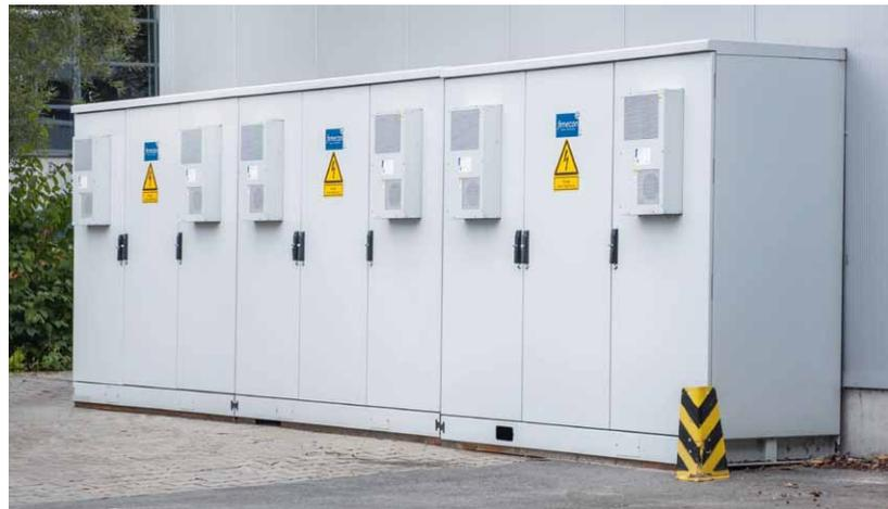
Dieser Stromspeicher von Fenecon steht auf dem Gelände einer Gießerei. Durch das Anfahren der Öfen und der Produktion entstehen dem Unternehmen kurzfristig extrem hohe Lastspitzen. Der Stromspeicher kann diese punktuell liefern. Zu den anderen Zeiten unterstützt er den Elektro-Auto-Ladepark.
