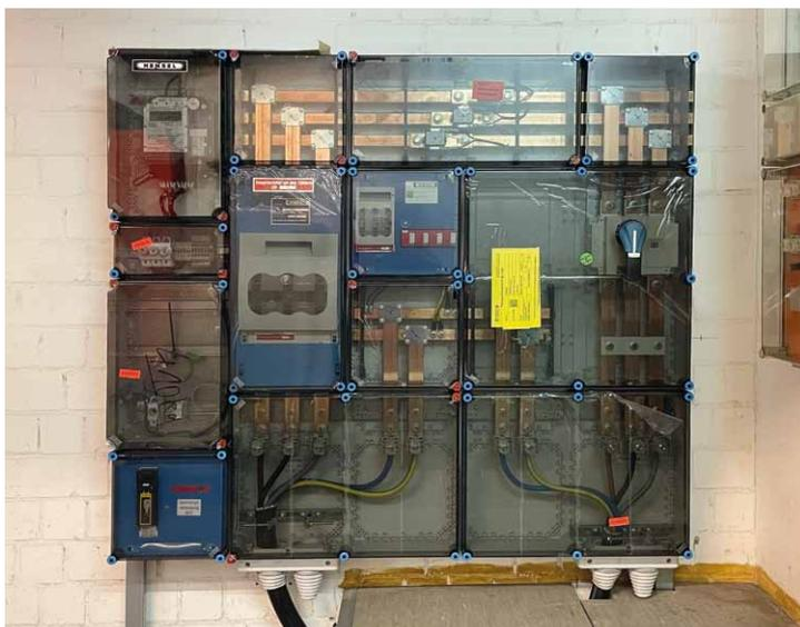
Schaltschrank zum Anschluss der Ladeinfrastruktur mit 170 Kilowatt Leistung. Rechts unten die Zuleitung, die zum Hauptschalter führt. Von dort geht es über die breiten Kupferleitungen zur Trennvorrichtung. Auf den Leitungen befinden sich die Sensoren, die mit dem Energiezähler verbunden sind. Unter der Trennvorrichtung ist die Leitung zur Ladesäule angeschlossen.
