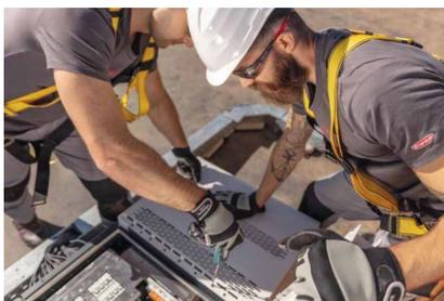
Mit dem Tauro 50-3-D bietet Fronius seine Wechselrichter auch als 50-Kilowatt-Version an. Mit einem Eingangsspannungsbereich von 200 bis 1.000 Volt und drei MPP-Trackern sei das Gerät für komplexere Dächer ausgelegt. Doppelwandig, mit IP 65 zertifiziert und ausgestattet mit einer aktiven Kühlung könne der Wechselrichter stehend oder liegend
